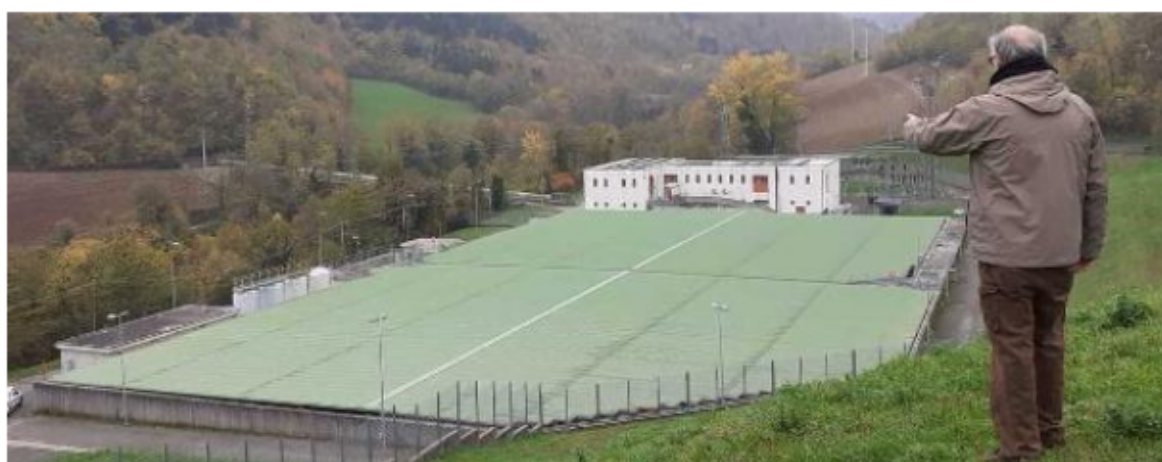
La centrale idroelettrica di Isola, frazione di Santa Sofia: costruita dopo la diga, ha circa trent'anni d'esercizio
